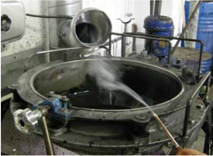
Abbildung 4: Überprüfung der Erfassungsqualität der Objektabsaugung mit Rauchröhrchen
